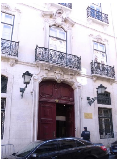
Fig. 3.206 – Pormenor do corpo central da fachada. Fonte: fotografia da autora, 2014.
