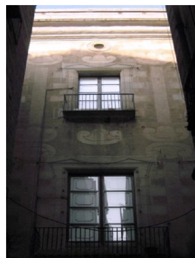
Fig. 2.48 - Pormenor dos esgrafitados na fachada do palácio.
