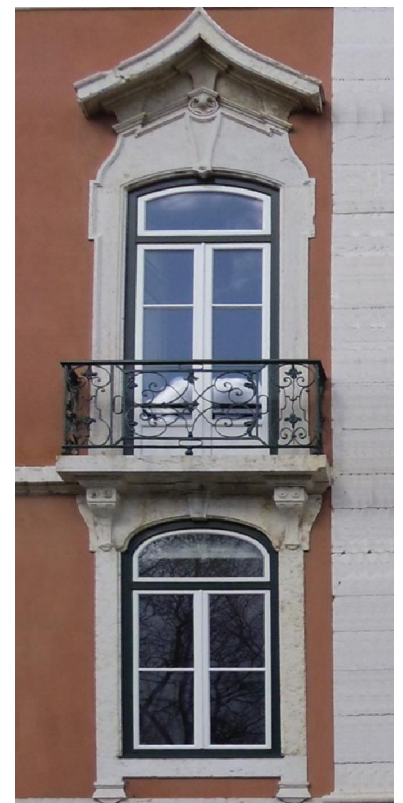
Fig. 4.243 – Pormenor da fachada do palácio Lavradio, na qual as janelas de sacada do andar nobre se articulam com o remate do vão inferior.
