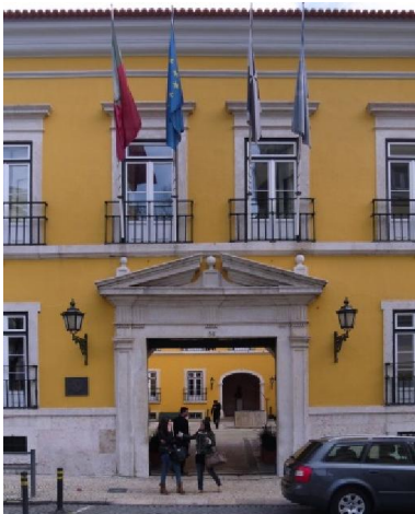
Fig. 3.139 – Pormenor do corpo central da fachada.
