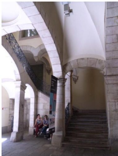
Fig. 2.77 - Escadaria do palácio.
