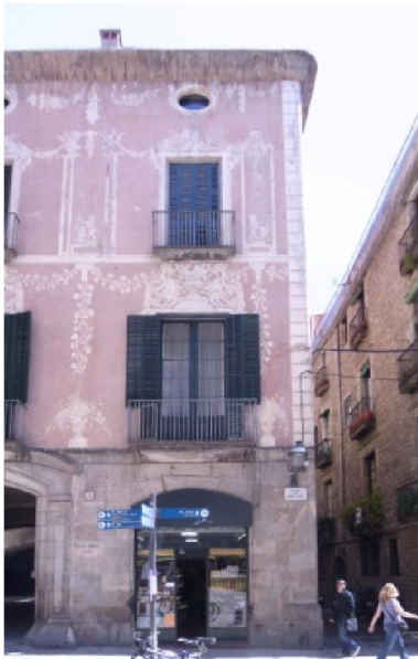
Fig. 2.64 - Os esgrafitados da fachada do palácio. Fonte: fotografia da autora, 2013.
