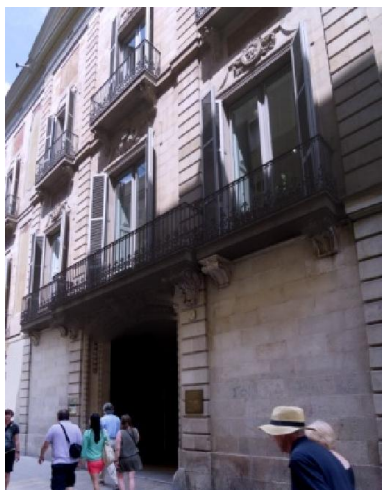
Fig. 2.106 - Pormenor do corpo central da fachada principal, na rua de Portaferrissa. Fonte: fotografia da autora, 2013.
