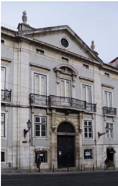
Fig. 3.195 – Pormenor do corpo central da fachada.
