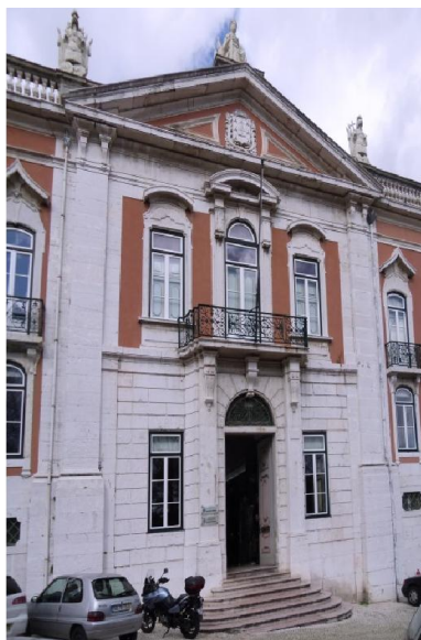
Fig. 3.173 – Pormenor do corpo central da fachada.
