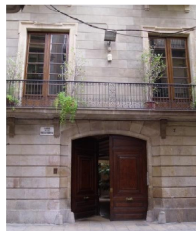
Fig. 2.58 - Pormenor do corpo central da fachada.
