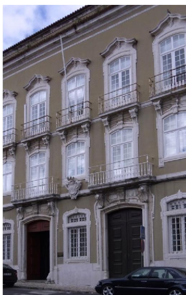
Fig. 3.160 – Pormenor do corpo central da fachada. Fonte: fotografia da autora, 2014.
