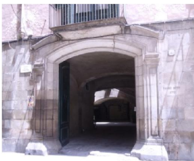
Fig. 2.65 - Portal nobre. Fonte: fotografia da autora, 2013.
