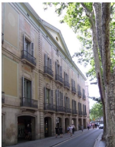
Fig. 2.107 - Fachada do palácio Moja voltada à Rambla. Fonte: fotografia da autora, 2013.
