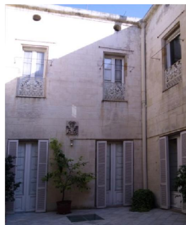
Fig. 2.68 - Pátio secundário na parte posterior do edifício. Fonte: fotografia da autora, 2013.
