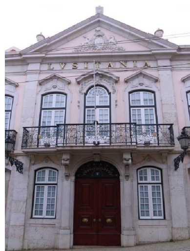
Fig. 3.186 – Pormenor do corpo central da fachada. Fonte: fotografia da autora, 2014.
