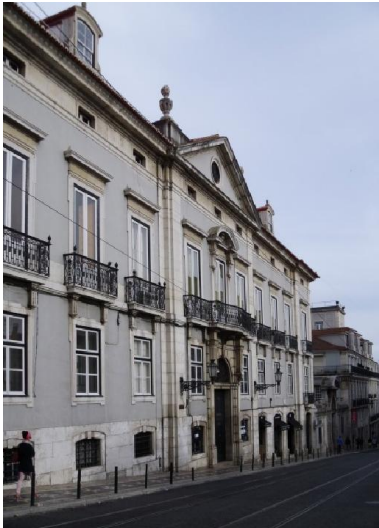
Fig. 3.194 – Fachada principal do palácio Quintela.
