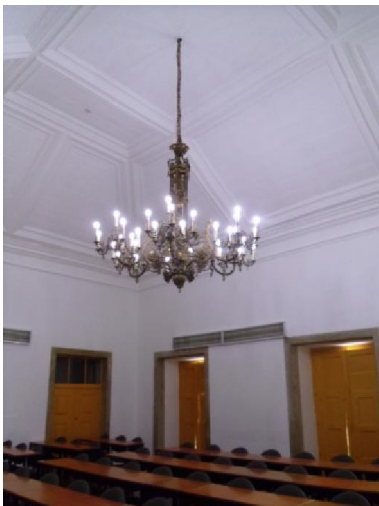
Fig. 3.145 – Sala com teto de masseira no andar nobre. Fonte: fotografia da autora, 2014.
