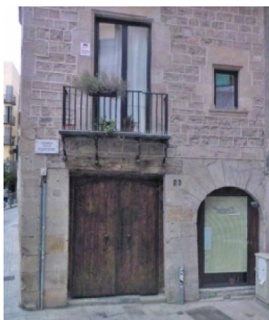
Fig. 2.32 – Edifício de habitação plurifamiliar, na rua de Carders, 23.
