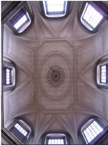
Fig. 3.203 – Cobertura da mesma sala de receção. Fonte: fotografia da autora, 2014.
