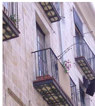
Fig. 2.34 - Pomenor da varanda, onde se nota a guarda em ferro forjado e o seu revestimento inferior em azulejos.
