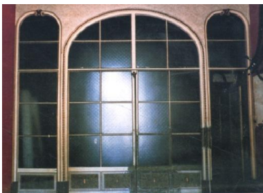
Fig. 2.99 - Portas em vidro que separam os espaços mais privados do palácio. Fonte: El Palau Marc: els March de Reus i el seu palau a la Rambla de Barcelona , 1987.
