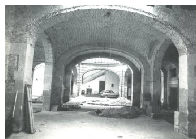
Fig. 2.95 - Pormenor das abóbadas da galeria do pátio. Fonte: El Palau Marc: els March de Reus i el seu palau a la Rambla de Barcelona , 1987.
