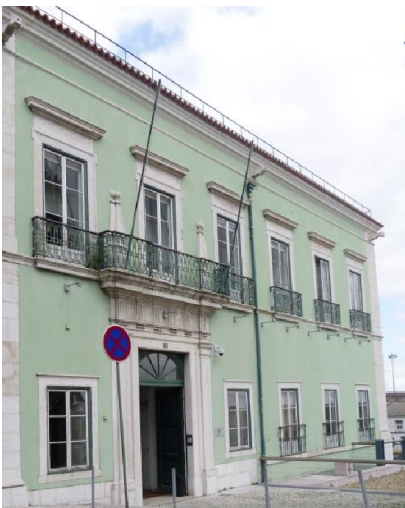
Fig. 4.248 – A expressão e ornamentação das fachadas dos palácios Braço de Prata, Quintela e do Manteigueiro Fonte: fotografia da autora, 2014.
