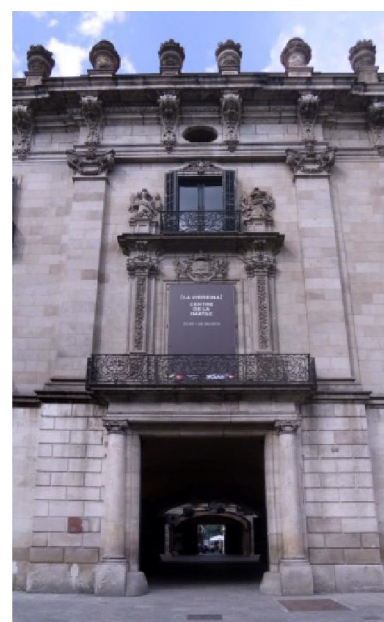
Fig. 2.74 - Pormenor do corpo central da fachada do palácio da Virreina.
