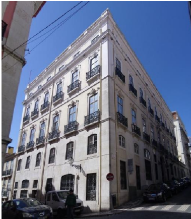
Fig. 3.205 – Fachadas do palácio do Manteigueiro. Fonte: fotografia da autora, 2014.
