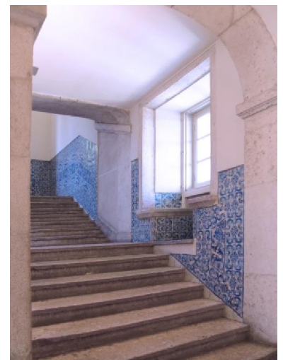
Fig. 3.132 – Escadaria do palácio.
