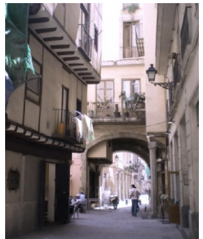
Fig. 2.30 – As volades no edifício à esquerda, na rua de Caputxes.
